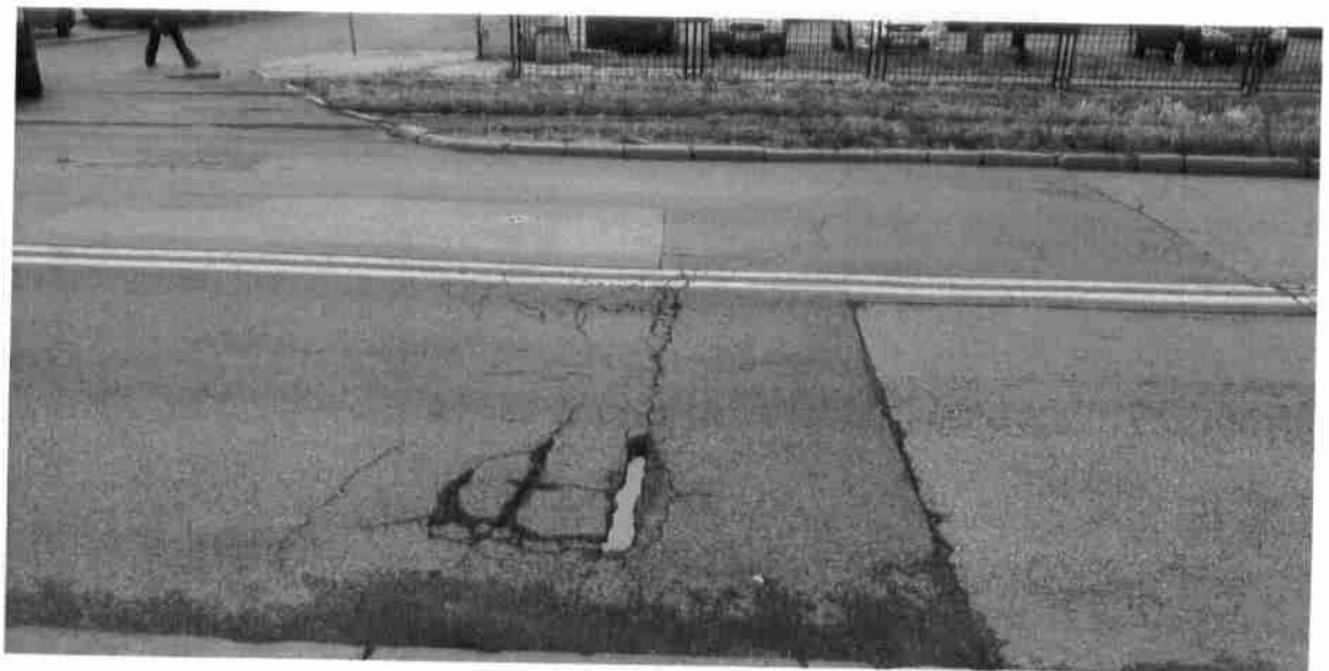
Ubytki w nawierzchni i zapadnięte wpusty ( w kompetencji MZDiM w Bytomiu) :
